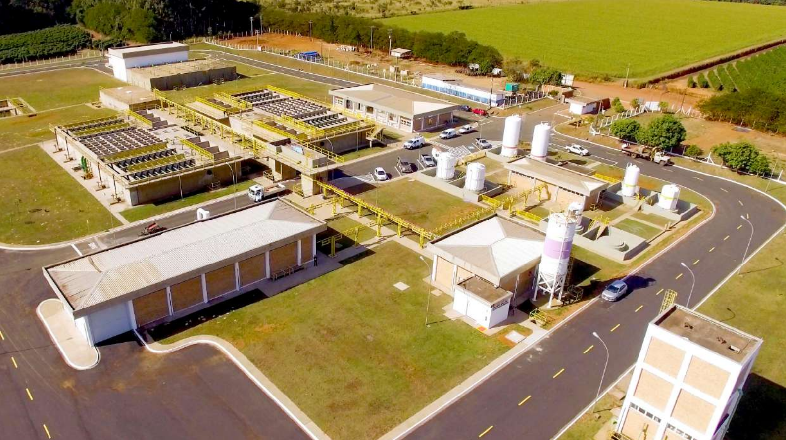
Estação de Tratamento de Água (ETA) Sapucaí-Mirim
