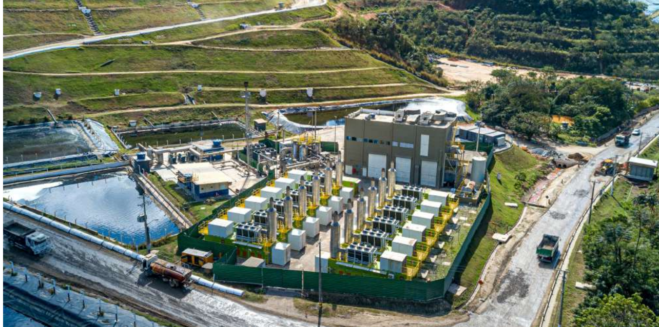
URE Barueri, primeira usina de geração de energia a partir da incineração de resíduos sólidos
