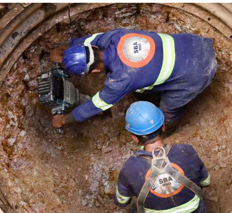
Colaboradores trabalhando na obra de expansão da rede de coleta de esgoto.
