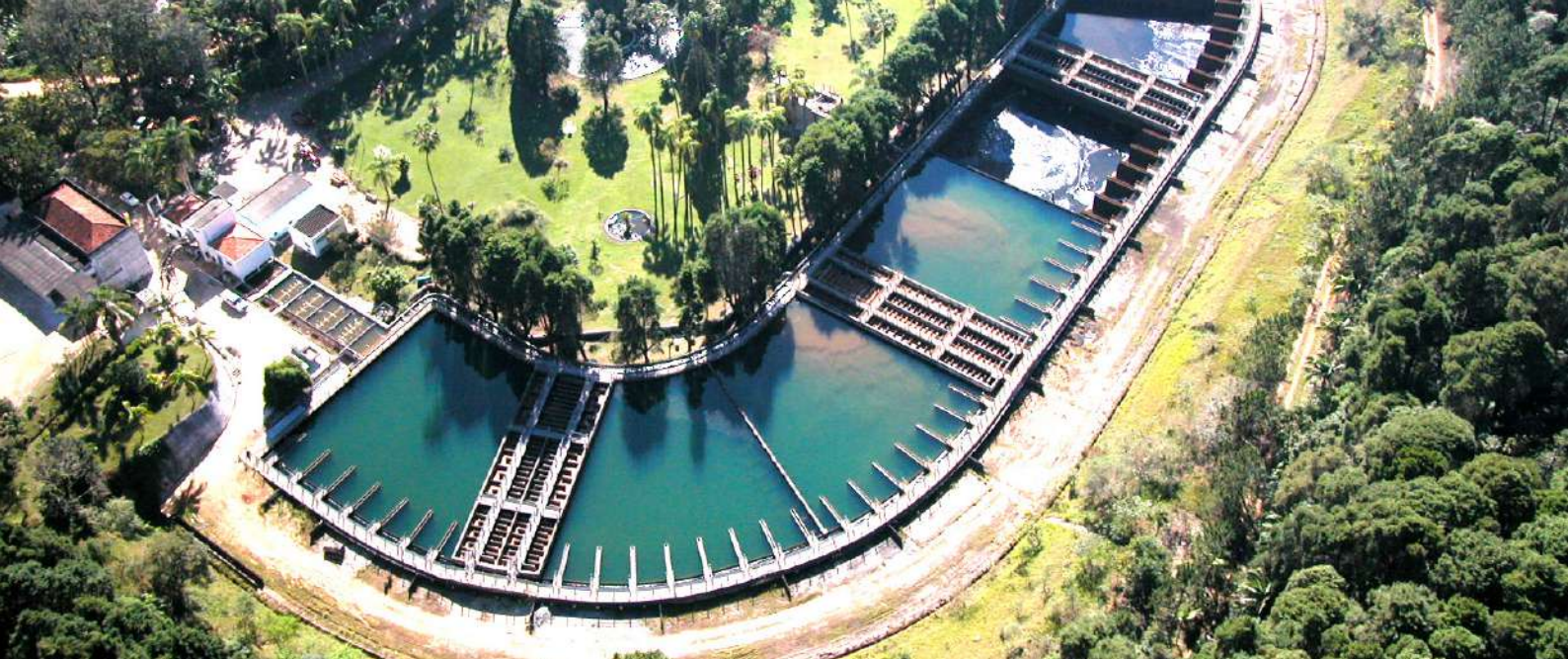
• Estação de Tratamento de Água Alto Cotia
